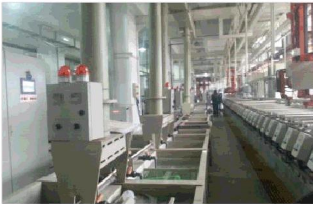
镀锌 (ZN) 自动生产线 Electro-galvanized Automatic Production Line(Zinc)
